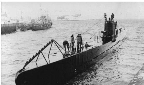
Подводная лодка тип «С» IX-бис серии заложена 24 ноября 1936 года на заводе №-194 (им. Марти) в Ленинграде. Секциями по железной дороге подводная лодка доставлена на Дальний Восток, где на заводе № - 202 (Дальзавод) во Владивостоке проводилась ее окончательная сборка. 5 ноября 1938 года С-54 спущена на воду. 31 декабря 1940 года подводная лодка вступила в строй, и 5 января 1941 года вошла в состав Тихоокеанского флота. Начало Великой Отечественной
