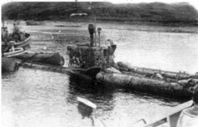
По мнению моряка-подводника старшего мичмана В. Казанова, шахта РДП (труба для подачи воздуха к дизелям с перископной глубины) на С-80 была шире, чем на других лодках. В тот день море штормило, и был хороший мороз. Вода, по-видимому, захлестывала шахту, и на верхней крышке намерз лед. Лодка пошла на глубину, а крышка не закрылась... Вода рванула в пятый отсек, где два моряка пытались уберечь корабль от катастрофы. Спасатели их там и нашли.
